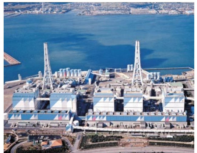
碧南火力発電所4、5号機の設備概要
