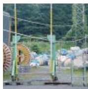
PS電線の弛度確認試験状況
