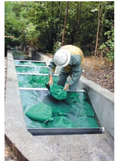
第22図 排水路に敷設した人工ゼオライト
