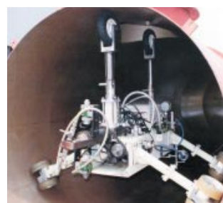
第14図 小口径循環水管塗装装置
