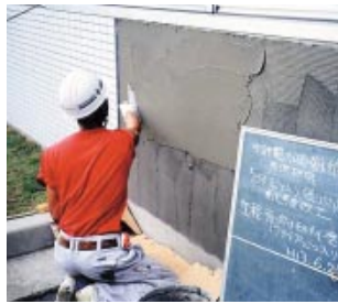
第18図 タイル貼付材料の施工状況
