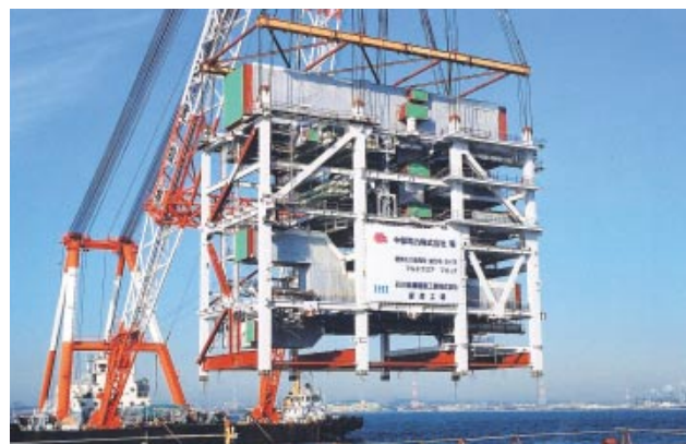
第3図 ボイラ大型ブロック工法
