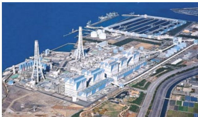
第1図 碧南火力発電所全景
