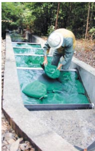
第5図 排水路に敷設した人工ゼオライト
