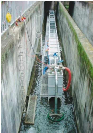
第1図 対象河道と試験水路設置状況
