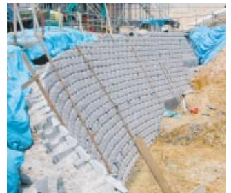
第12図 石炭灰使用ブロック施工状況
