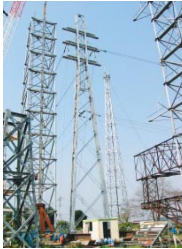
第5図 H鋼鉄塔 試験体全景
