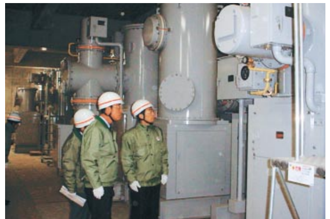
変電所建設工事視察状況
