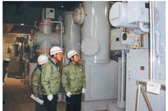
変電所建設工事視察状況
