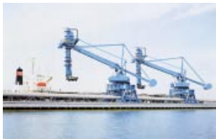
第9図 アンローダ(揚炭機)
