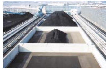
第11図 4,5号機専用半地下屋外式貯炭場
