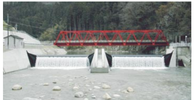
第5図 ゴム堰起立状況
