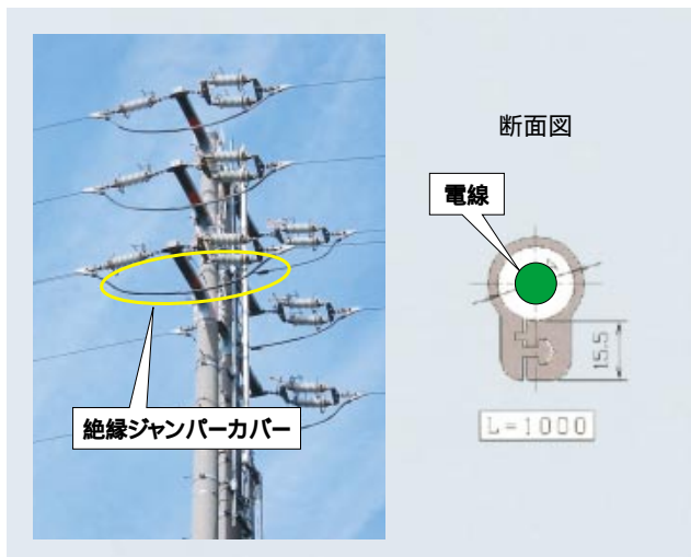
第1図 絶縁ジャンパーカバーの取付状況
