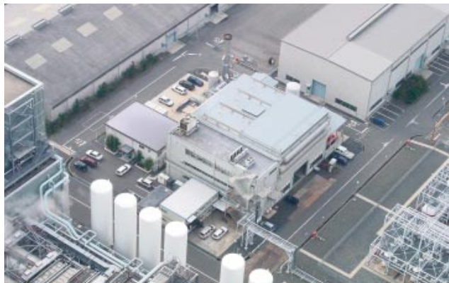
写真1 川越MCFC発電試験所全景
