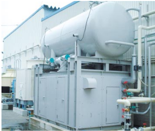
第3図 実証試験機の外観図 (L5,000×W2,000×H4,000)
