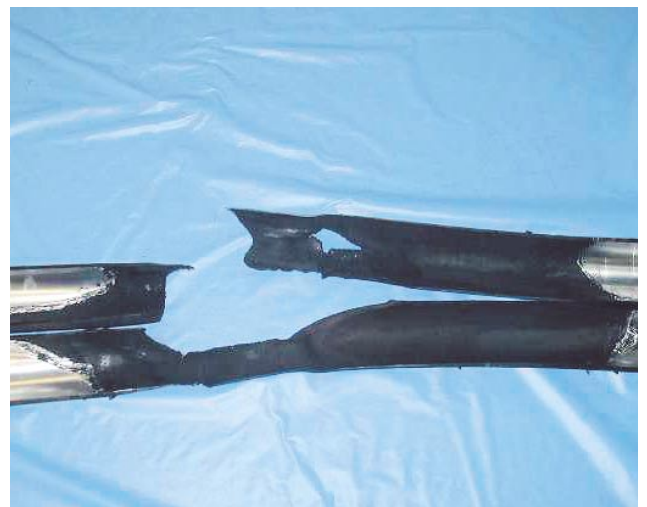
第4図 遮水・遮蔽層の溶損状況
