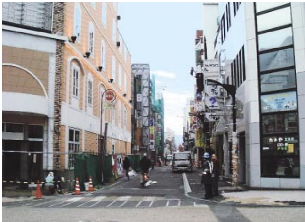
第3図 街路灯柱方式ソフト地中化整備状況
