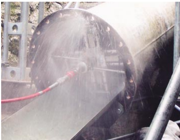
第5図 超高压水によるケレン状況
