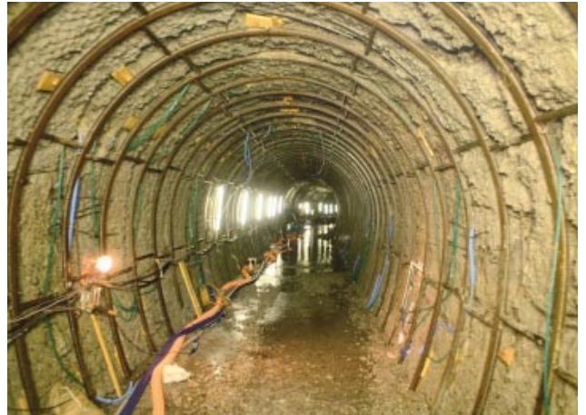
第4図 鋼製支保工設置状況
