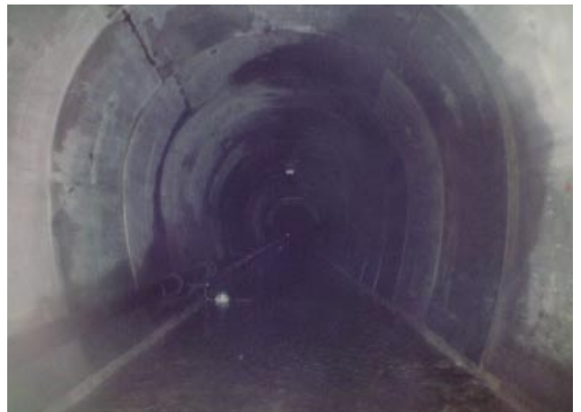
第5図 改修後の水路トンネル
