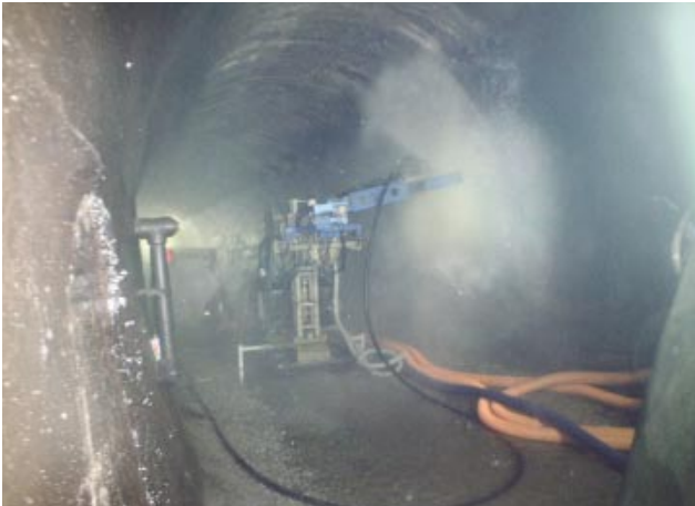
第3図 ウォータージェット工法
