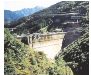
石炭灰を利用した滝沢ダム
