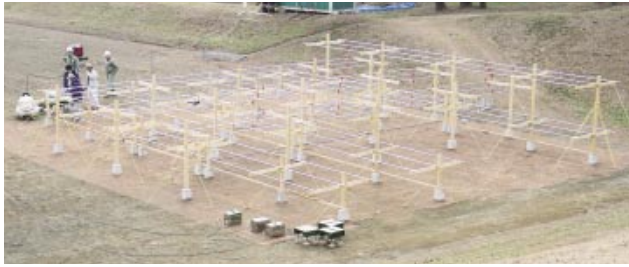
第4図 モデル変電所
