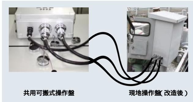
第5図 操作時のケーブル接続状況
