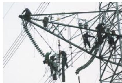
第2図 V吊懸垂がいし装置の取替状況
