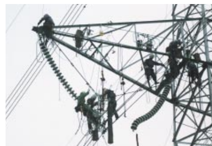
第2図 V吊懸垂がいし装置の取替状況
