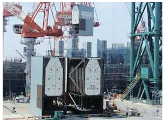
第19図 大ブロック化工法の適用例(復水器)
