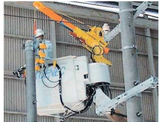
第3図 高機能ウインチによる高圧腕金取付作業
