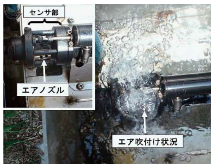
第6図 センサ部へのエア吹付け状況
