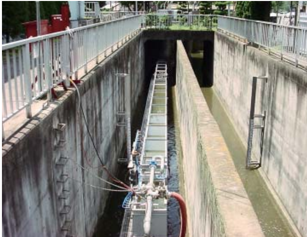
第2図 対象河道と試験水路設置状況
