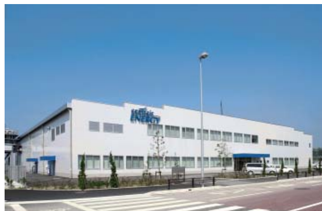
第2図 エネルギーセンター
