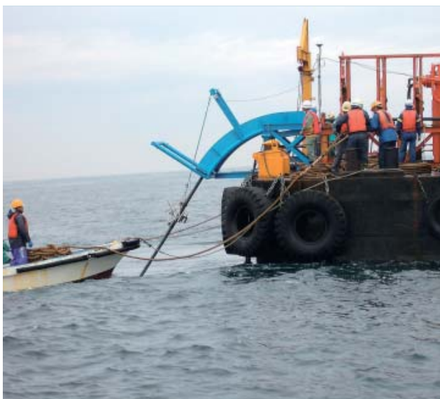
第4図 曳航布設
