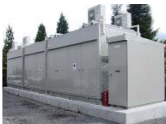
高圧電気二重層キャパシタ式瞬低補償装置 (2000kVA、2秒補償)
