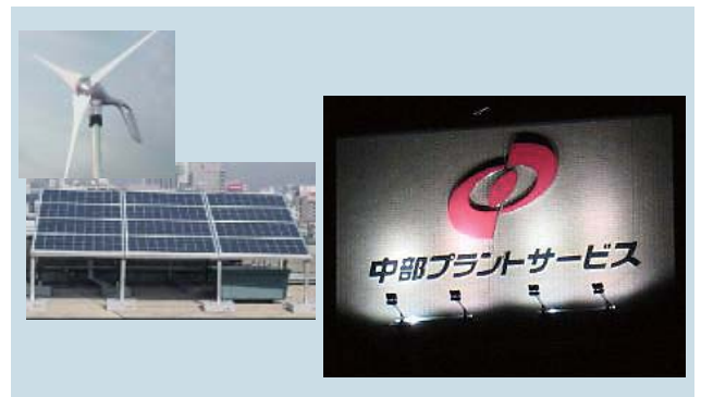
太陽光 / 風力ハイブリッド発電システム
