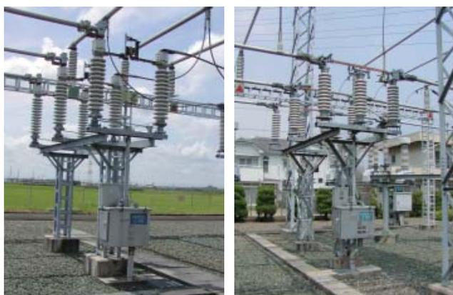
第1図 断路器(左:水平一点切タイプ、右:水平二点切タイプ)
