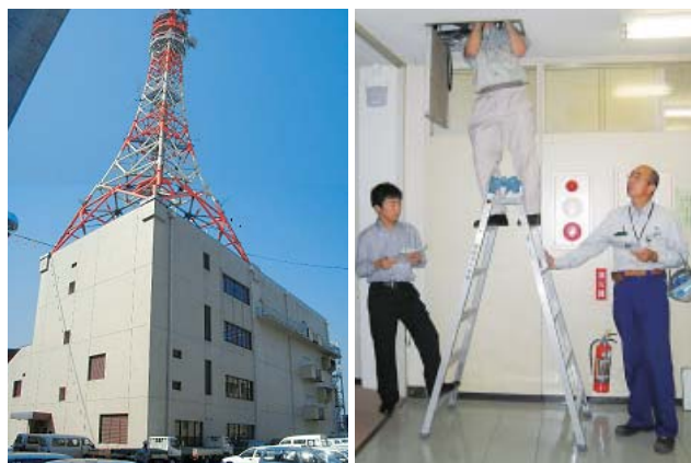
第4図 静岡支店西館と現地調査状況
