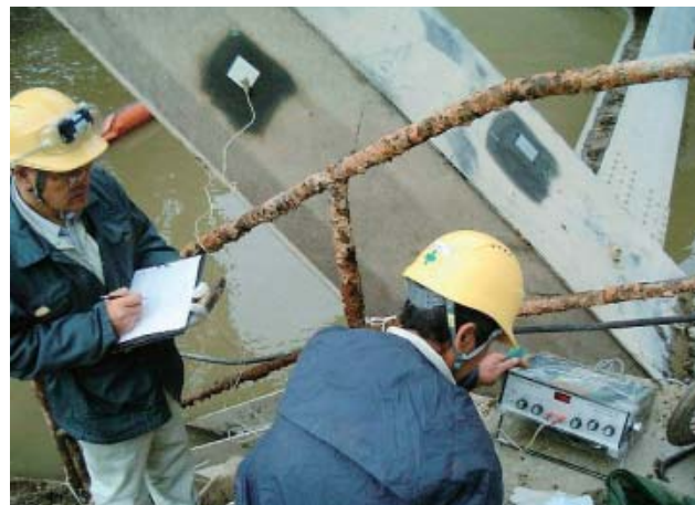
第2図 既設塗膜調査状況
