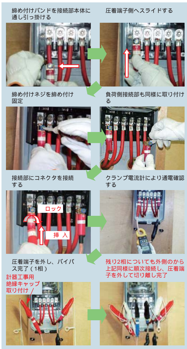
第1図 接続端子の取り付け方法
