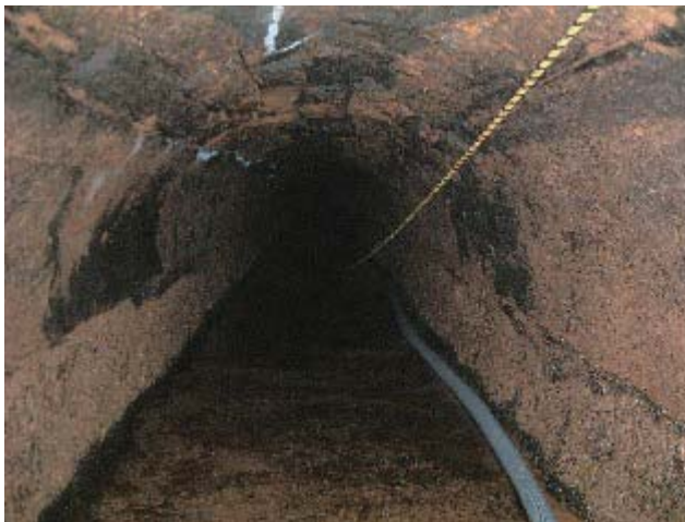
第4図 導水路トンネル内状況
