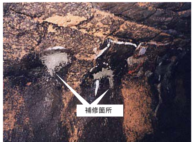
第6図 モルタル補修状況
