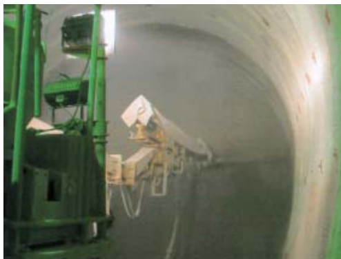
写真1 トンネル吹付け試験状況
