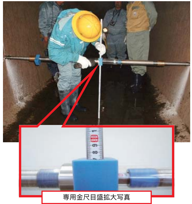
第5図 洗掘量測定状況
