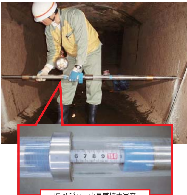
第4図 水路幅測定状況
