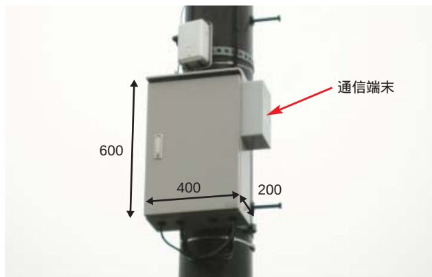
第3図 通信機能付標定装置の装柱状況
