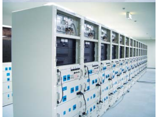
第3図 シミュレータのオペレーションルームと系統モデル
