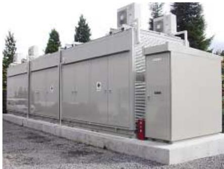
電気二重層キャパシタ式瞬低補償装置(2000kVA、2秒補償)
