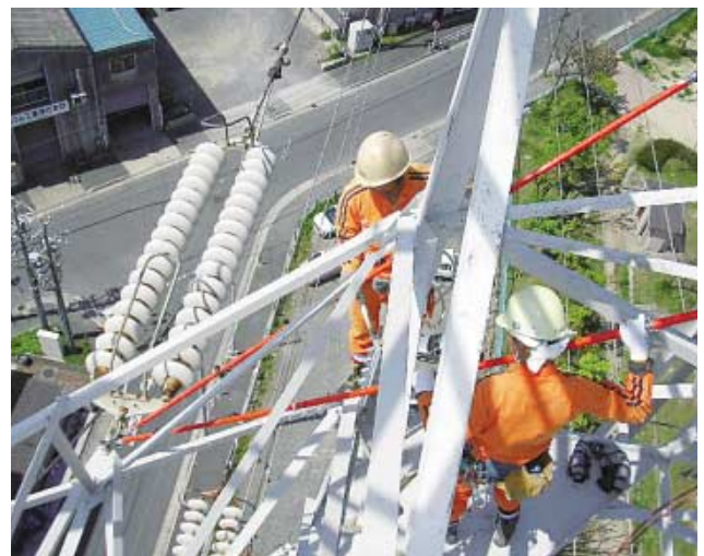
第5図 架線金具補修状況
