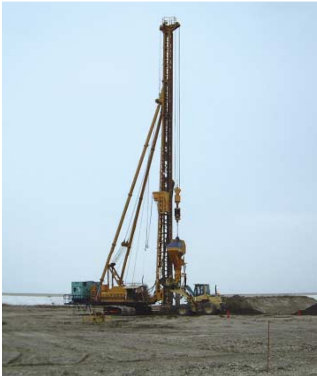
写真1 地盤強化工法( SCP )の施工状況
