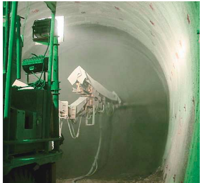
第20図 トンネル吹付け工事への利用状況
