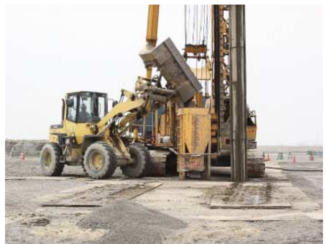
第18図 クリンカアッシュを用いた施工状況
