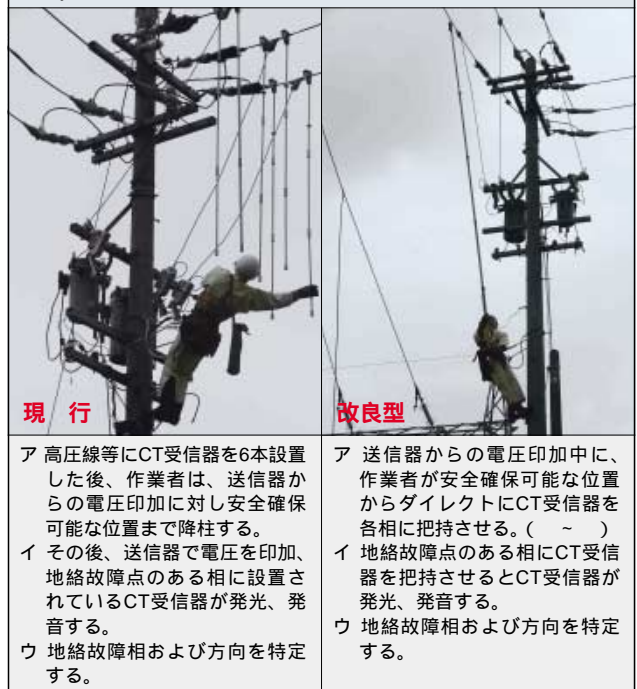
第2図 CT受信器による地絡故障点探査
