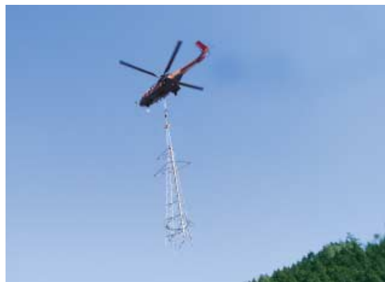
撤去鉄塔の運搬
