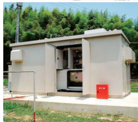
写真4 マイクロガスタービン発電装置
