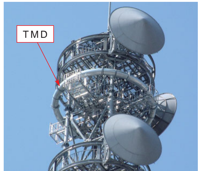
写真2 既設通信鉄塔へのTMD適用事例
