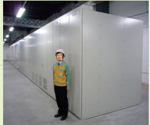
高圧電気二重層キャパシタ式瞬低補償装置 (10000kVA、1秒補償、屋内仕様器の例)
