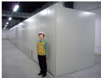
高圧電気二重層キャパシタ式瞬低補償装置(10,000kVA、1秒補償)
