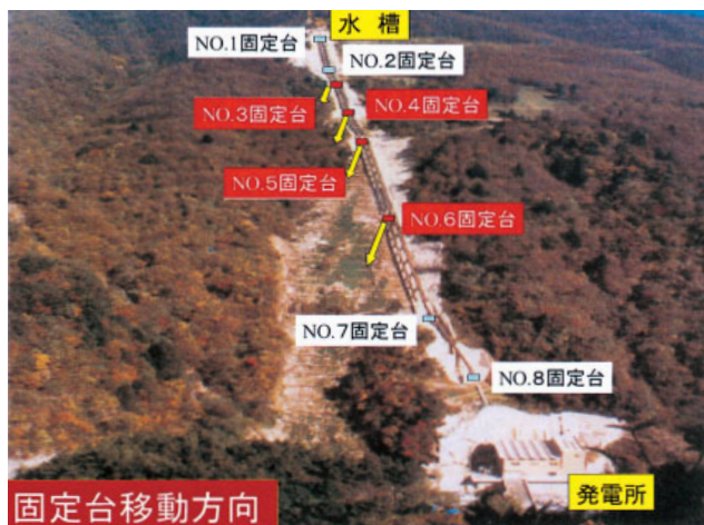
第1図 発電所の鉄管路斜面の例
