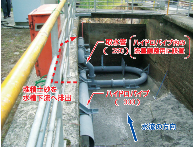
第2図 ハイドロパイプの設置状況
